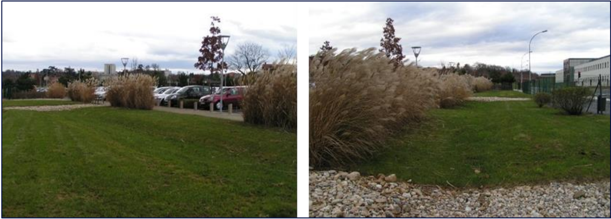
Figure 3: Exemple de noues d'infiltration le long d'un parking (CHU Lyon Sud)
